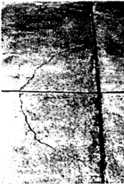
(L): Nứt tại góc tấm, bề rộng vết nứt < 13 mm, tấm không lún.
