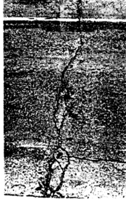
(M): Vết nứt có chiều rộng > 10 mm, bắt đầu có hiện tượng nứt thứ cấp xung quanh. Chiều rộng cả nứt chính và nứt thứ cấp đến 75 mm.
