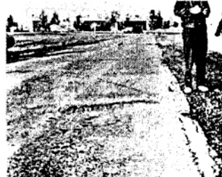
(M): Hiện tượng lỗi lõm ảnh hưởng đến chất lượng chạy xe. Người điều khiển phương tiện thấy khó chịu do mặt đường bị xóc.
