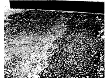
(H): Hiện tượng lỗi lõm ảnh hưởng nghiêm trọng đến chất lượng chạy xe. Lái xe không thể chạy với tốc độ cao trên các đoạn lỗi lõm.
