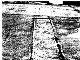
(M): Vết vá bắt đầu bị hư hỏng, quanh mép vá, vật liệu bắt đầu bị rộp vỡ.
