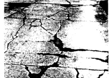
(H): Tấm bị nứt vỡ thành nhiều miếng nhỏ (> 6 phần).
