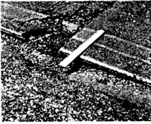
(L): Chênh cao giữa mặt đường và lề từ 20 mm đến 50 mm.
